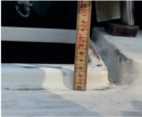
4 Mål fundamentet op for de ny glideskinner. Bemærk at der er niveauforskel så det gamle fundament skal hæves 10 mm.
