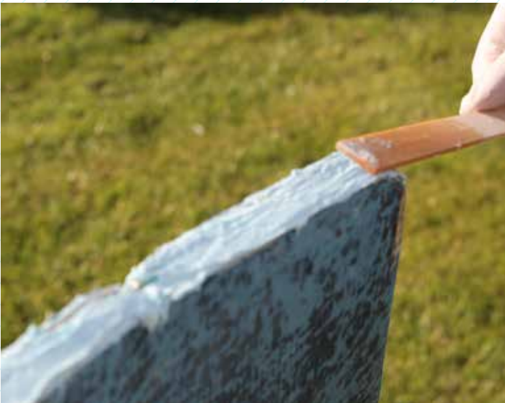
19 Forøg tykkelsen på spartlingen. Spartelmassen synker lidt under hærdningen. Jævn evt. overfladen med fugepind dyppet i sæbevand. Der skal være nok spartelmasse at slibe ned.
