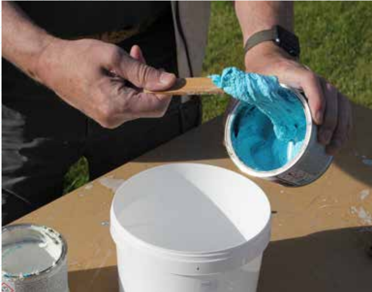
17 Bland Profair Filler i forholdet en del hæder til en del base. Rør grundigt i blandingen, så farven bliver ensartet.
