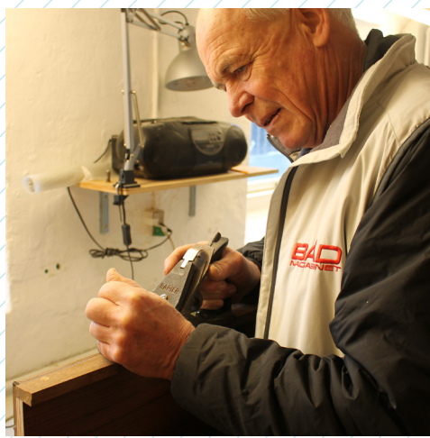
28 Jævn proptoppene med en skarp høvl, så den er flush med kantlisten.
