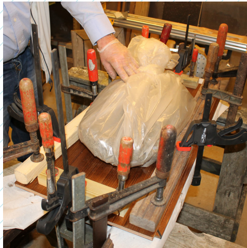
18 Forøg evt. limtrykket med sandsække, mursten eller sten. Brug skruetvinger og sørg for at kantlistens øverste del flugter med overkant.
