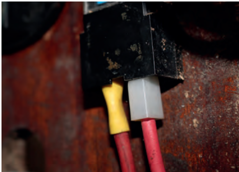
8 Til flere kortplottere kobles en 1A sikring på 12 volt plus rød ledning. Kobl den røde ledning til bådens 12 volt plusledning og den sorte ledning sættes på bådens minusledning, som også er instrumentledning.
