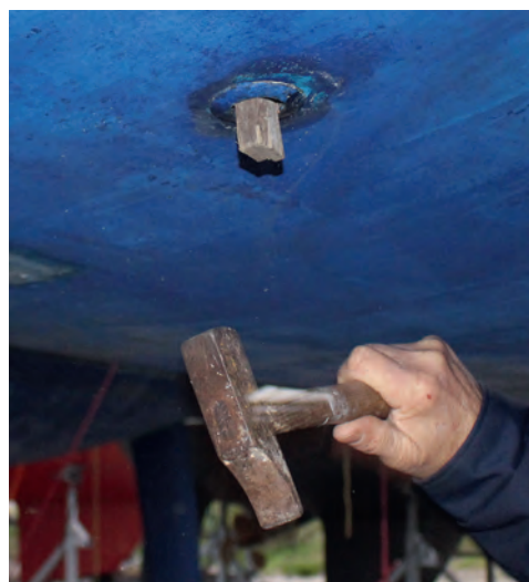
17 Slå en tilspidset træstok i gennemføringen for centring for det efterfølgende \varnothing 45 mm savbor.
