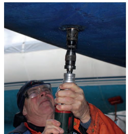
18 Det \varnothing 45 mm bimetal savbor skar brystet af gennemføringen. Hold boremaskinen lidt skråt og kød med få omdrejninger. Den savede gennemføring var lige til at slå ind med en hammer.
