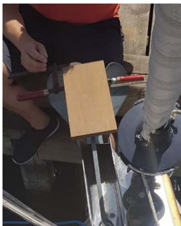
8 Læg det tilskårne fodtrin på vangerne i lidt epoxylim. Husk at affedte teaktræet med acetone inden samlingen.
