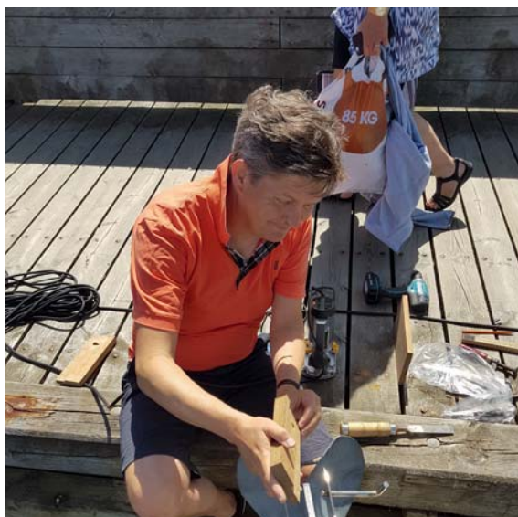
6 Afprøv om den passer på ankerholderen. Marker med blyant hvor der skal tages mere af eller slibes.
