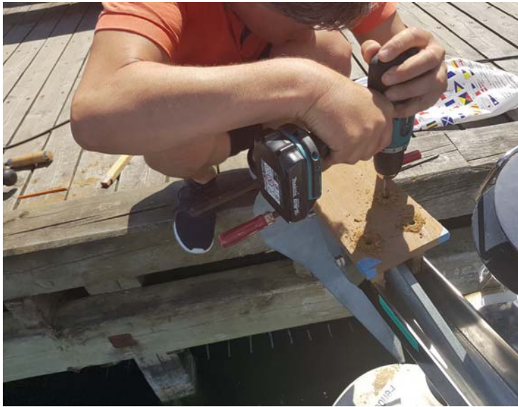
11 Brug et 10 mm kunstbor i det forborede hul så der i overkanten af hullet dannes en skarp kant, der passer præcist til den efterfølgende 10 mm teakræprop.
