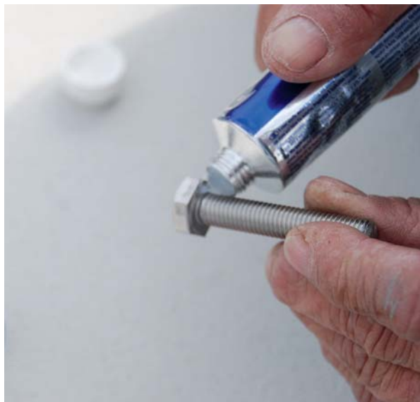
17 Forsegl begge bolte i hovedet og ved gennemboringen med sealant.
