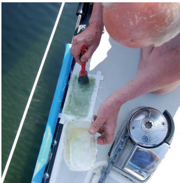
9 Afdæk reparationsområdet med tape, og påfør epoxy samt tilklippet glasvæv i tre lag. Mæt reparationen med epoxy.
