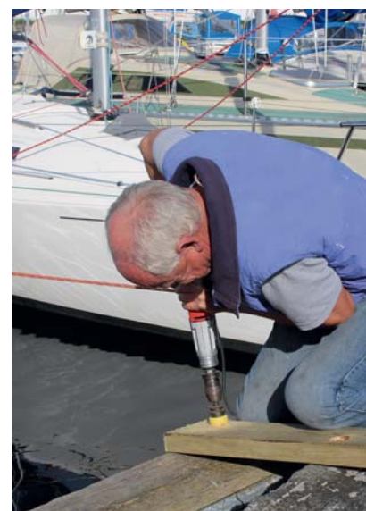
3 Bor huller til møtrikker og gevindstænger så brofenderen kan skrues op til et plant anlæg.
