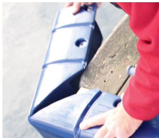
9 Sæt den ene ende af brofenderen på med rustfrie skruer og skiver. Bøj fenderen rundt om hjørnet, og sæt den anden del fast. For ikke at fenderen bøjes op ved højvande, skal alle skruer monteres i huller under.
