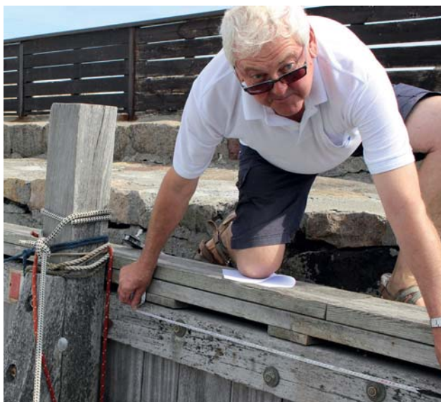
1 Opmål afstanden mellem fortløjningspunkterne på molen. Afhængig af molehammerens udførelse kan der sættes et nyt brofender-anlæg op.
