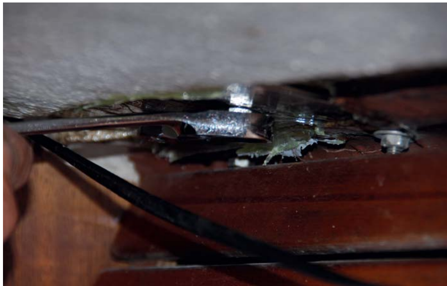
19 Placer begge bolte i hullerne, og spænd skiver og møtrikker nedfra hårdt med top- eller stjern nøgle.
