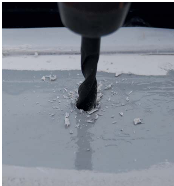
15 Forbor med 10 mm bor til det første boltehul. Sæt klampen på dækket og sæt klampen i hullet.
